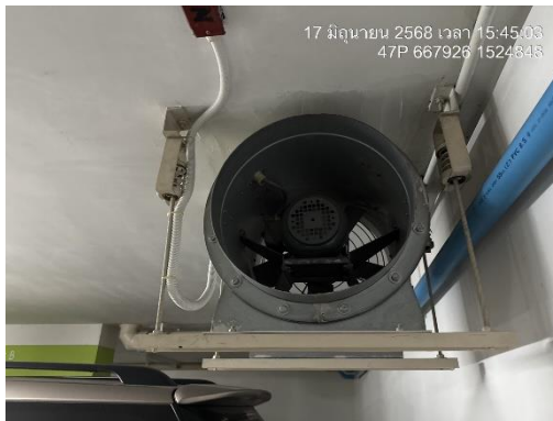
รูปที่ 2 การระบายอากาศภายในพื้นที่ จอดรถด้วยพัดลมระบายอากาศ
